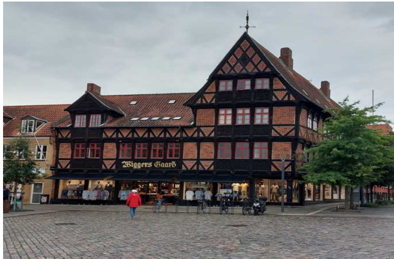
Fachwerkhaus in Sonderburg
