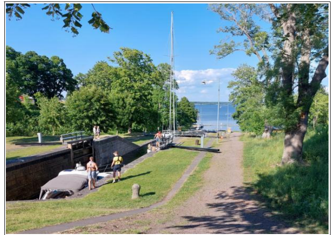
Ein Blick auf die Treppenschleusen
