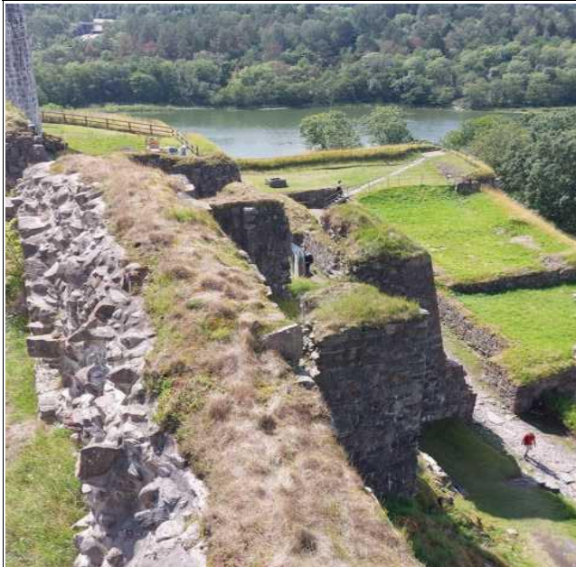
Blick von der den gewaltigen Mauerresten
